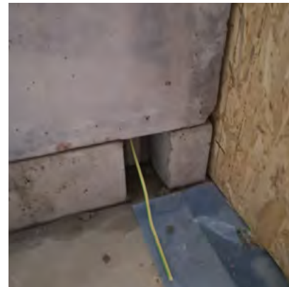
(9) Aussparung für das Erdungskabel im Sockelelement.
