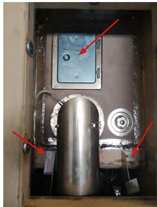
(9) Transportsicherung lösen. Es genügt die Verschraubung an der Betonplatte vollständig zu entfernen.
