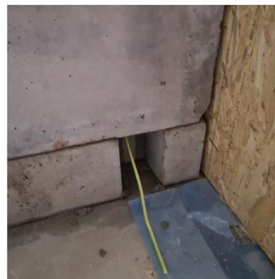
(9) Aussparung für das Erdungskabel im Sockelelement.
