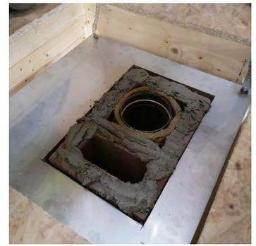
(4) Deckeneinbindungselement mit vorbereiteter Stoßfuge
