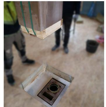
(6) Das Fertigteil langsam über die Stoßfuge führen.
